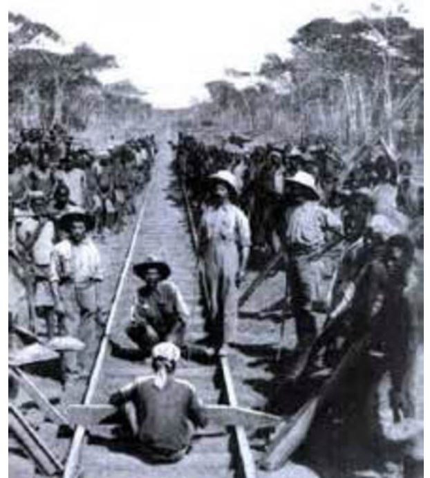
Doc2 - Construction ligne de chemin de fer Congo-Océan, 1924
